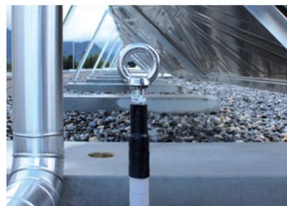
Die Schrumpfschläuche haben eine innenseitige Kleberbeschichtung für einen absolut dichten, dauerhaften Abschluss ohne Wartungsfuge.
