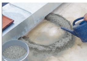
**5** Dichtigkeitsprüfung der behandelten Reparaturstelle
